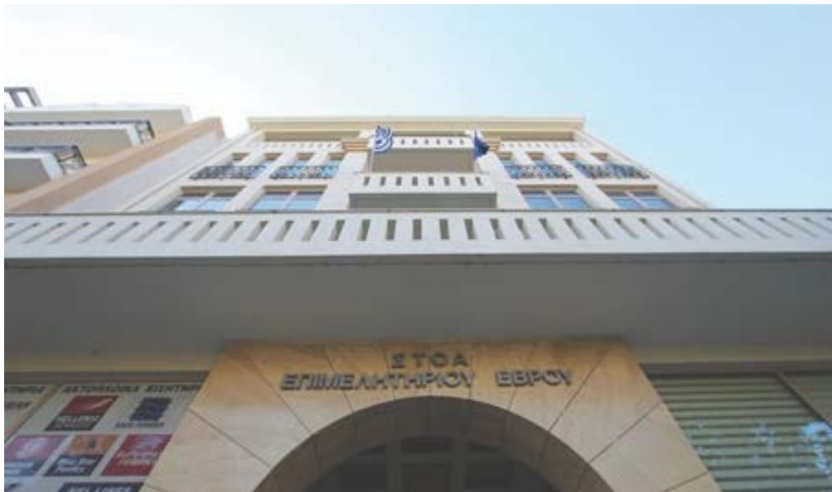
Το νέο κτίριο του Επιμελητηρίου Έβρου.
